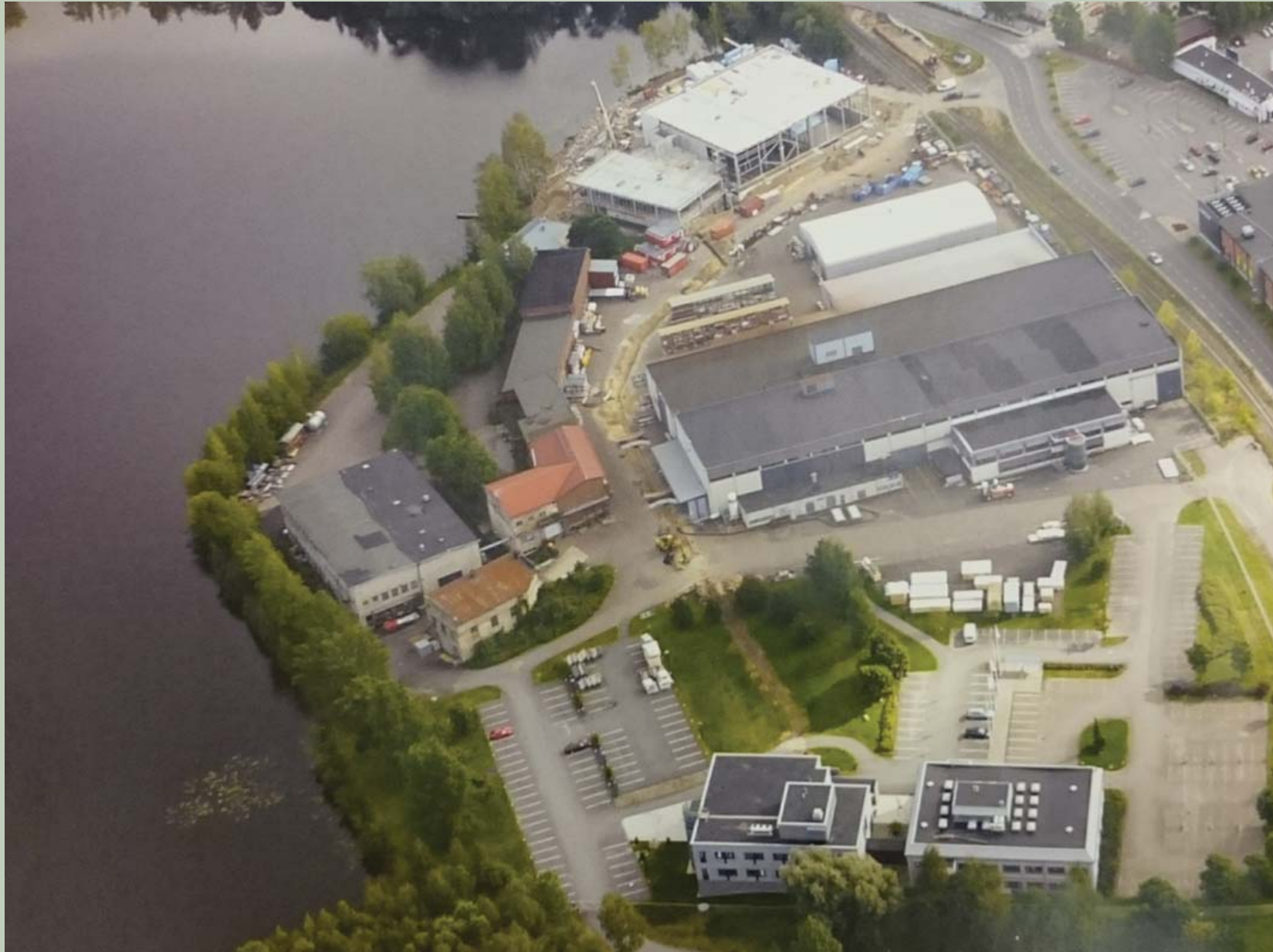
KUVA 4. Selvitysalue kuvattuna vuonna 2014, kun uusi tutkimuskeskus on rakenteilla (Pitkänen 2015, 158)
